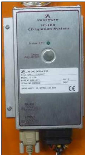
FIG. 5.10. Modulo Controlador da Ignição.
