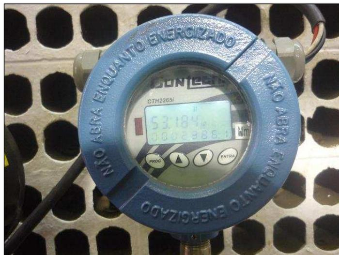
FIG. 5.8. Medidor da Vazão do *GN*.
